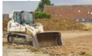
Début des travaux sur le chantier de Chambray-lès-Tours à la mi-juillet.
